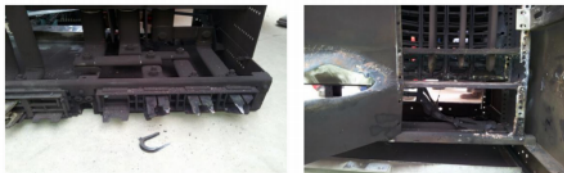
图 1 低压柜抽屉因触头发热导致短路故障图
