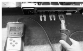
图 2 低压柜抽屉一次触头夹紧力检测仪实测图
