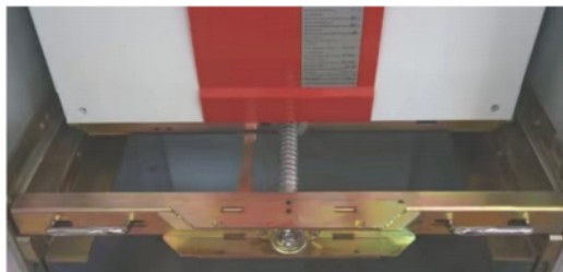
图2 底盘中丝杆带动断路器推进、退出
