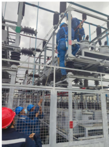
图 1 更换电容现场图
