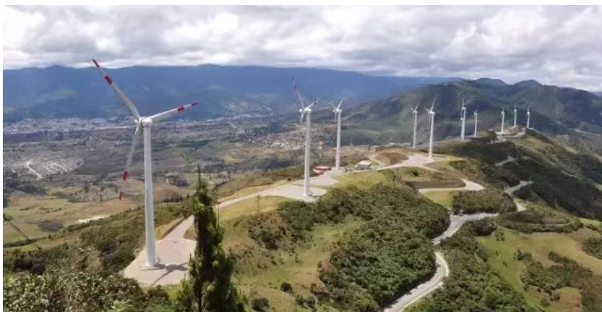
创造世界纪录的金风科技厄瓜多尔安第斯山 VILLONACO 风电场
