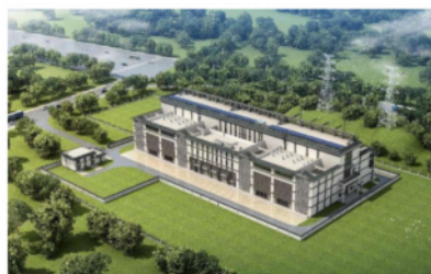
图 13 苏州越溪 500kV 全户内变电站效果图
